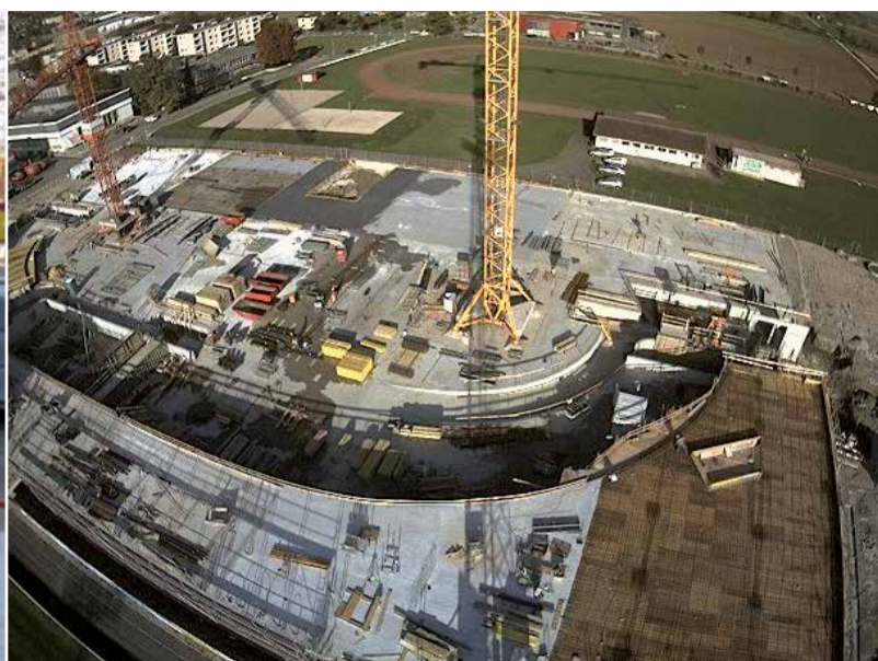
22. Oktober 2012 Das Velodrome Suisse von Oben. Der Herbst 2012 steht im Zeichen der Betonierarbeiten – jeden Tag fahren mehrere Lastwagen mit Flüssigbeton zur Velodrome Suisse-Baustelle.
