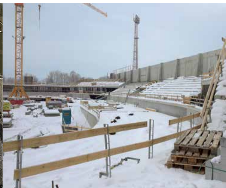
November / Dezember 2012 Trotz teilweise schwierigen Wetterbedingungen verläuft der Baufortschritt im November und Anfang Dezember sehr erfreulich. Der Bau der Tribünen ist weit fortgeschritten und die Betonierarbeiten der Laden- und Büroräumlichkeiten befinden sich im Abschluss.
